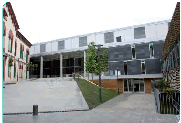
Part posterior del nou edifici de consultes externes
