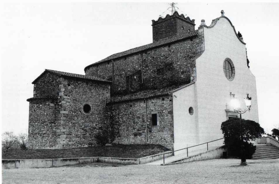
L'església parroquial després de les obres de restauració de la façana
