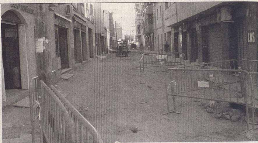
Tot i les molesties actuals, les obres milloraran la qualitat urbana del centre històric
