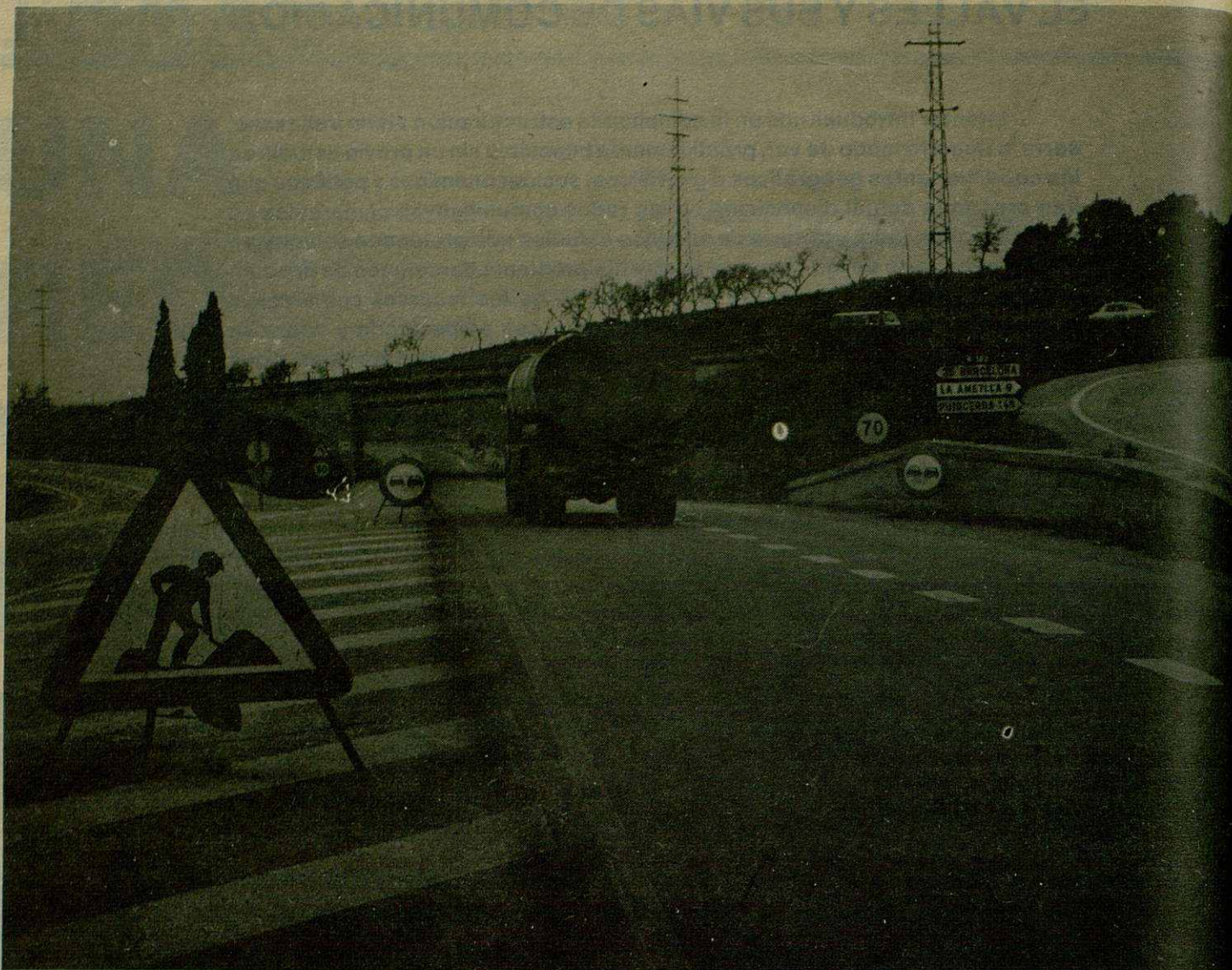
Nada más salir de Granollers, unas obras que duran demasiado en una curva que es un cepo abierto.
