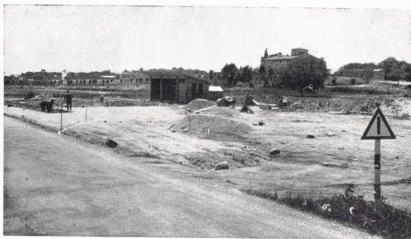
Obras para la instalación de una estación de servicio
