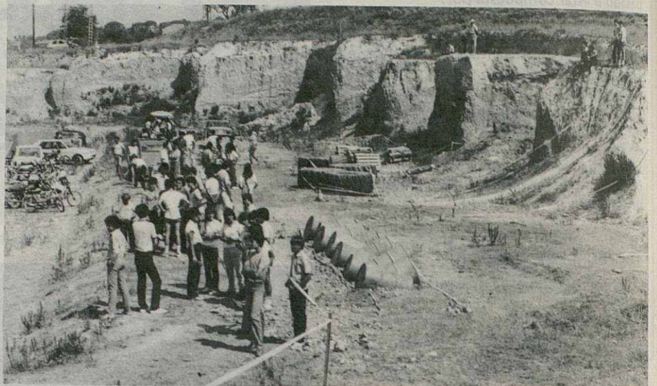
Vista general del Circuito.
