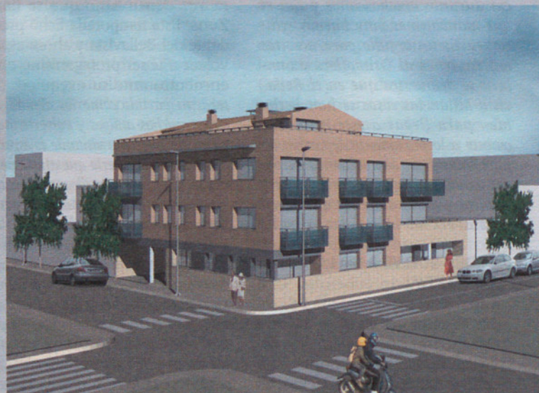
Granollers. Pisos de 2 i 3 hab. i dúplex amb terrassa
