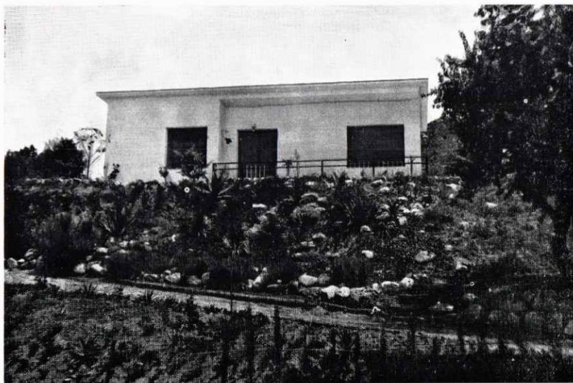
Chalet construido para D. José Calahorra Mañero en las cercanías de la ermita de S. Cristóbal. Empresa constructora: Construcciones del Vallés, S. A.
