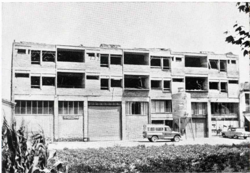
Bloque en construcció en la carretera de Barcelona, destinat a domicili social de C.O.V.A.S.A., oficines y vivendes.
