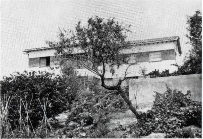
Edificio nuevo en la finca "Can Met", propiedad de COVASA
