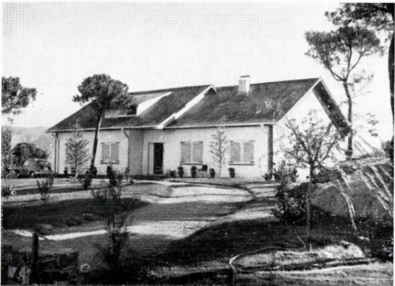
Casa construida por COVASA para D. Enrique Molist Orri,
