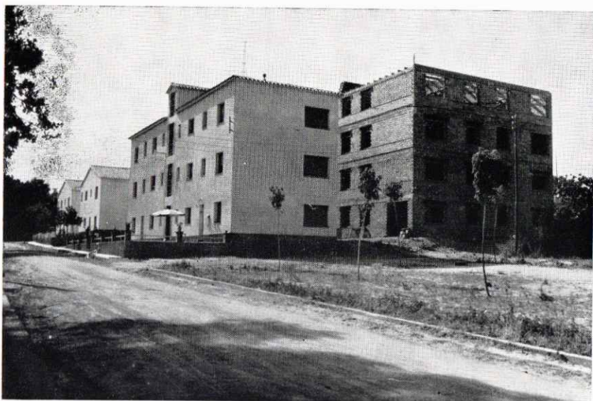
Bloques de viviendas construidos para el Sr. Enrique Torras en la calle Virgen del Remedio. Contratista: D. José Gurri Ballús
