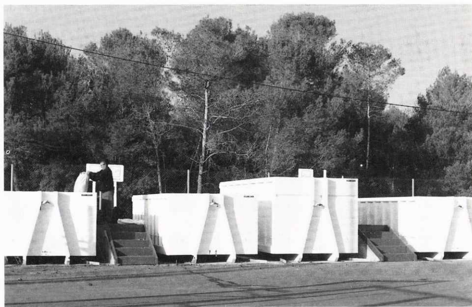
La nova deixalleria, ja en funcionament.
