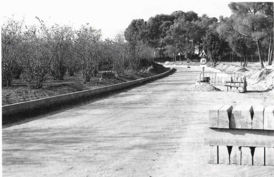
Obres de pavimentació del Camí de la Serra davant l'ermita de Sant Simple.
