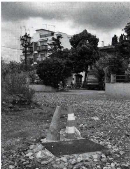
El sector de Can Careta ja disposa de connexió a la xarxa de clavagueram.
