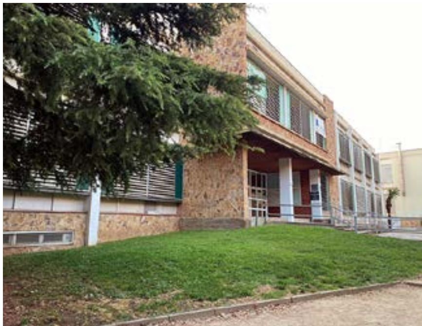
L'Escola Municipal de Treball, de 6.115 metres quadrats, es convertirà en un edifici autosuficient energèticament gairebé al 100 %
