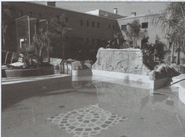
Una gran piscina está situada justo encima del centro termal al que se puede acceder por un ascensor panorámico.
