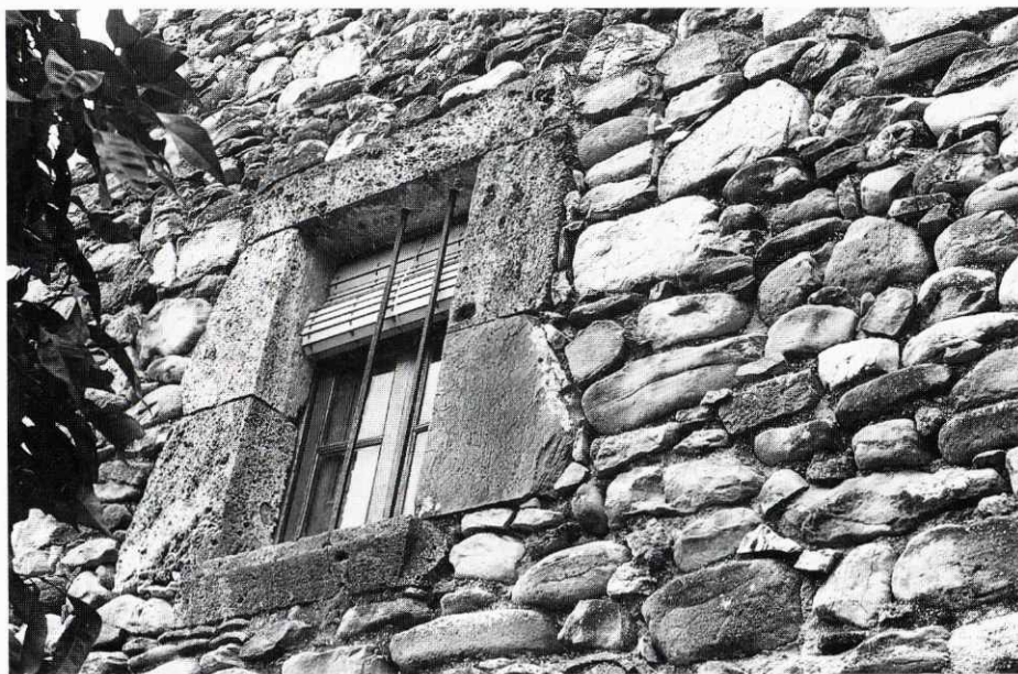
Detall d'una finestra de llinda plana.
