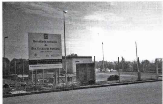
La deixalleria de Santa Eulàlia, en construcció
