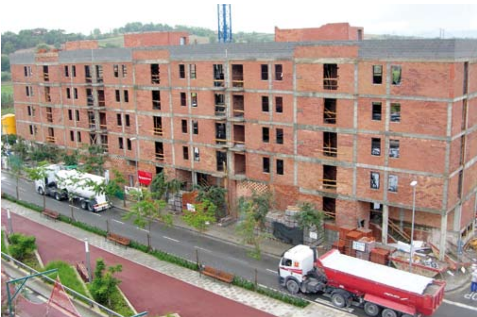
Construcció de 40 habitatges a l'av. Marie Curie, 26-32
