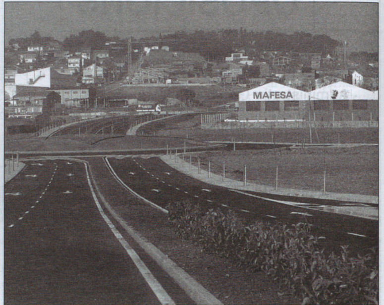
Todo el tramo del puente que sobrepasa el Passeig de la Ribera hasta la rotonda de Can Gurgui está prácticamente terminado.
