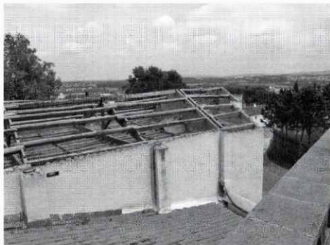
Obres de reforma de la teulada del Casal Parroquial.
