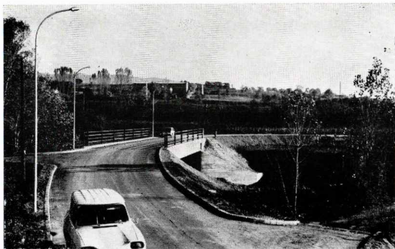
El nou pont de Can Donat i el carrer asfaltat i enllumenat, ja acabats definitivament.
