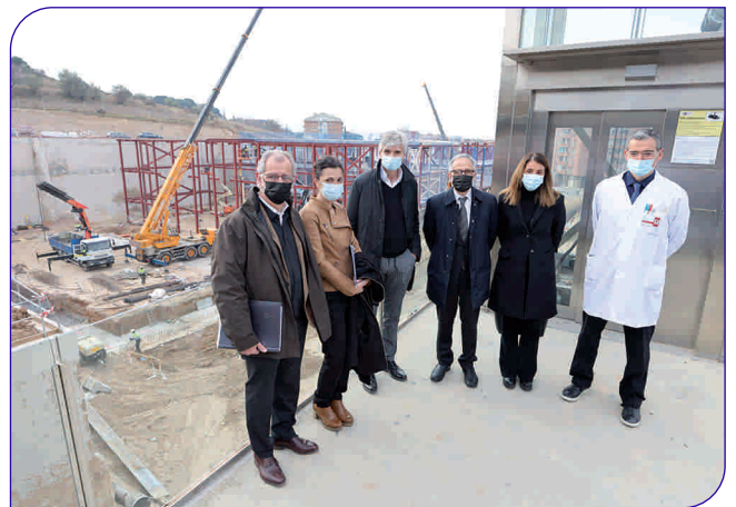
Argimon va poder veure l'evolució de les obres de l'Edifici Compacte
