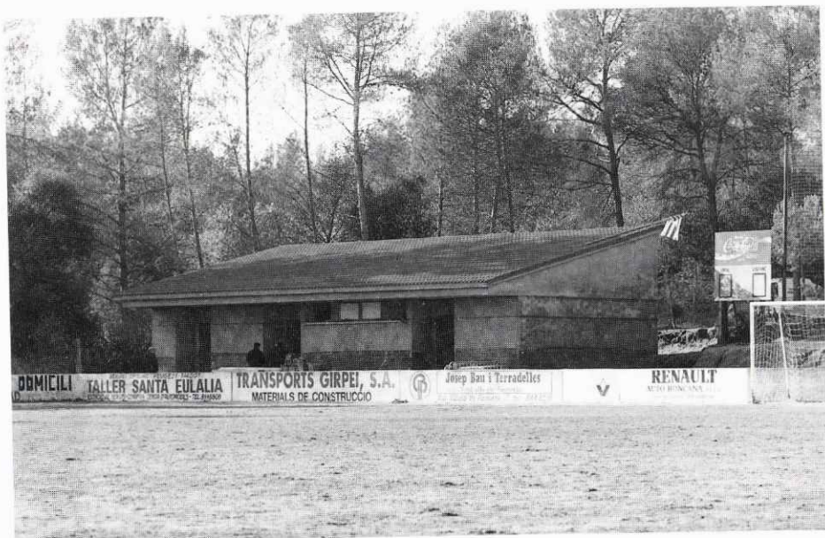
Els nous vestuaris que es construeixen en el Camp de Futbol.
