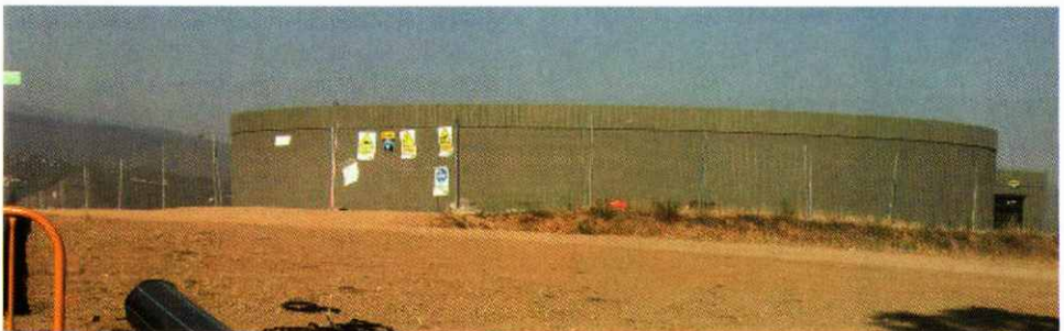
Nou dipòsit pel subministrament d'aigua potable.
