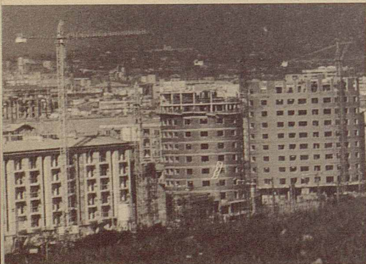
Habitatges de protecció oficial a Tres Torres
