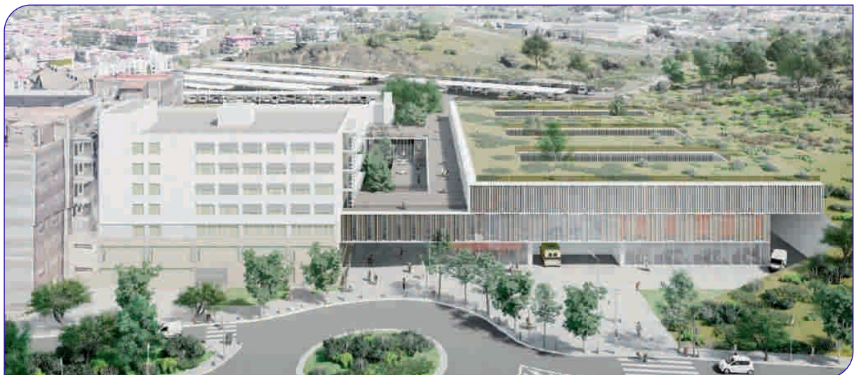
La nova construcció s'emmarca en el projecte d'ampliació i modernització de l'hospital per fer front a la pandèmia i a la postpandèmia de la covid-19
