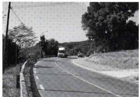
Revolt de Can Baró, amb el marge rebaixat.
