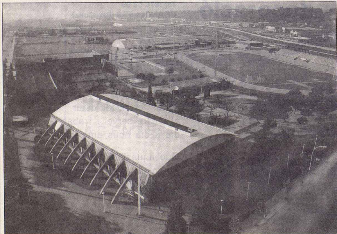
Vista general de las instal·lacions del complexe municipal
