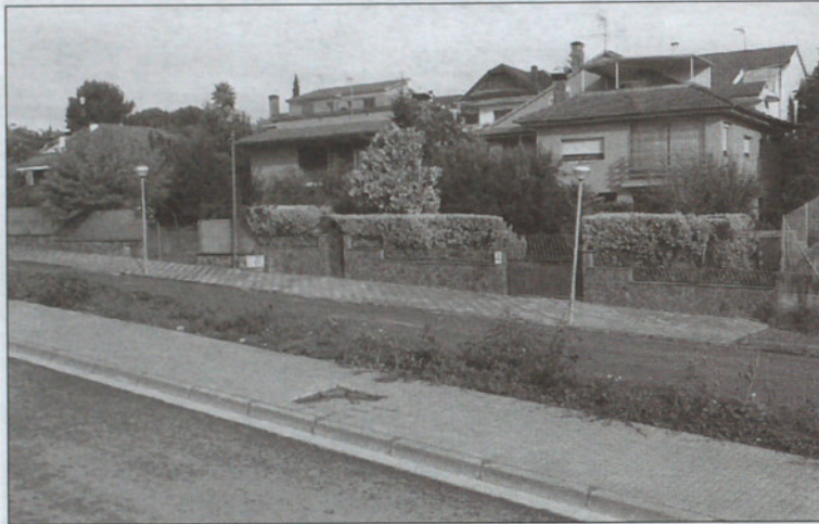
La forma como se hacen las obras de la Ronda alarman a los vecinos.
