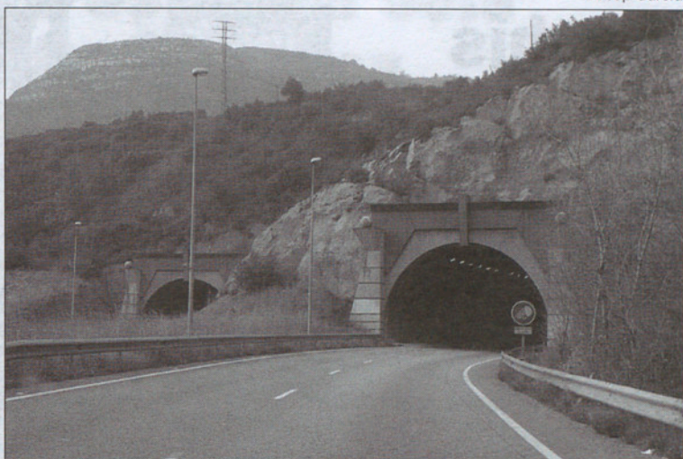
Túnel de Figaró por donde circulaba contra dirección y marcha atrás uno de los conductores detenidos.
