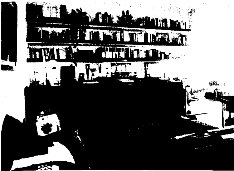
Zona biblioteca-lectura a nivel superior. Estantería de obra con sobre de madera y un sólo bloque inferior suspendido en la pared.
