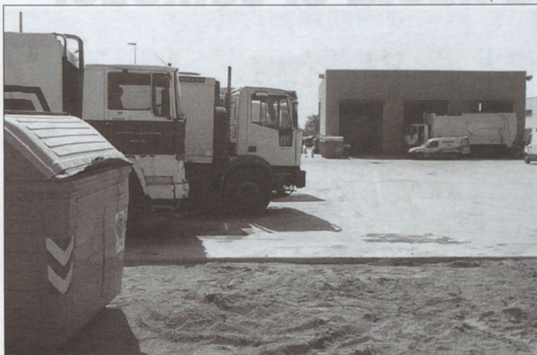
Instalaciones de Urbaser, en Palou donde se produjo el accidente mortal.
