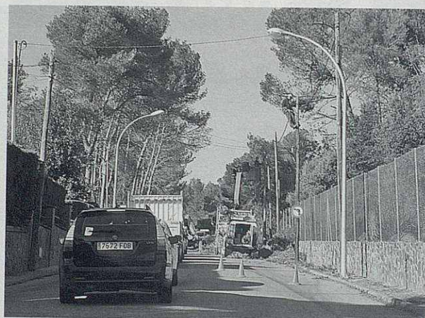
Reparació al camí de Can Vendrell.
