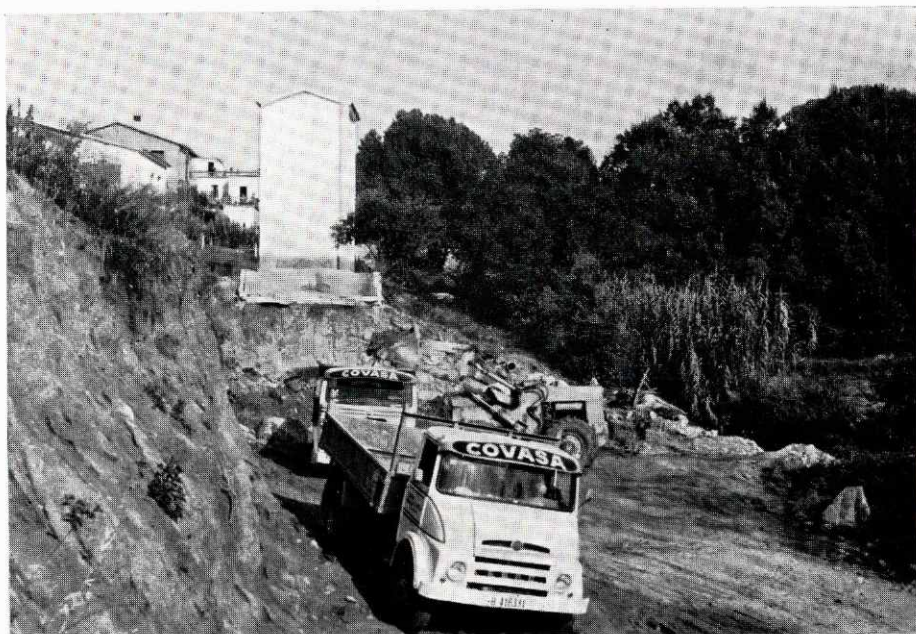
Comienzo de las obras del nuevo edificio de la plaza del Ayuntamiento.
