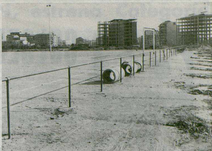
Detalle del inicio de las obras del vallado del campo municipal de fútbol de Les Franqueses.
