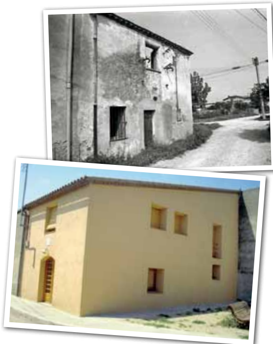
A DALT, L'ANTIC AJUNTAMENT DE PALOU ABANS DE LA REHABILITACIÓ DE L'EDIFICI QUE ES VA CONVERTIR EN CENTRE CÍVIC. FOTO: JOSEP NOGUÉS. A SOTA, DESPRÉS DE LA REHABILITACIÓ (1986). AUTOR I FONTS: PERE CORNELLAS/ARXIU MUNICIPAL DE GRANOLLERS
