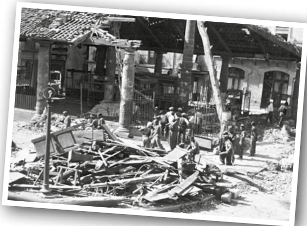
LA PORXADA VA PATIR AMB EL BOMBARDEIG DESPERFECTES EN L'ANGLE SUD-EST, JA QUE ES VA DESPLOMAR PART DE LA COBERTA AL PARTIR-SE DIVERSES COLUMNES. FOTO: BIBLIOTECA NACIONAL DE ESPAÑA
