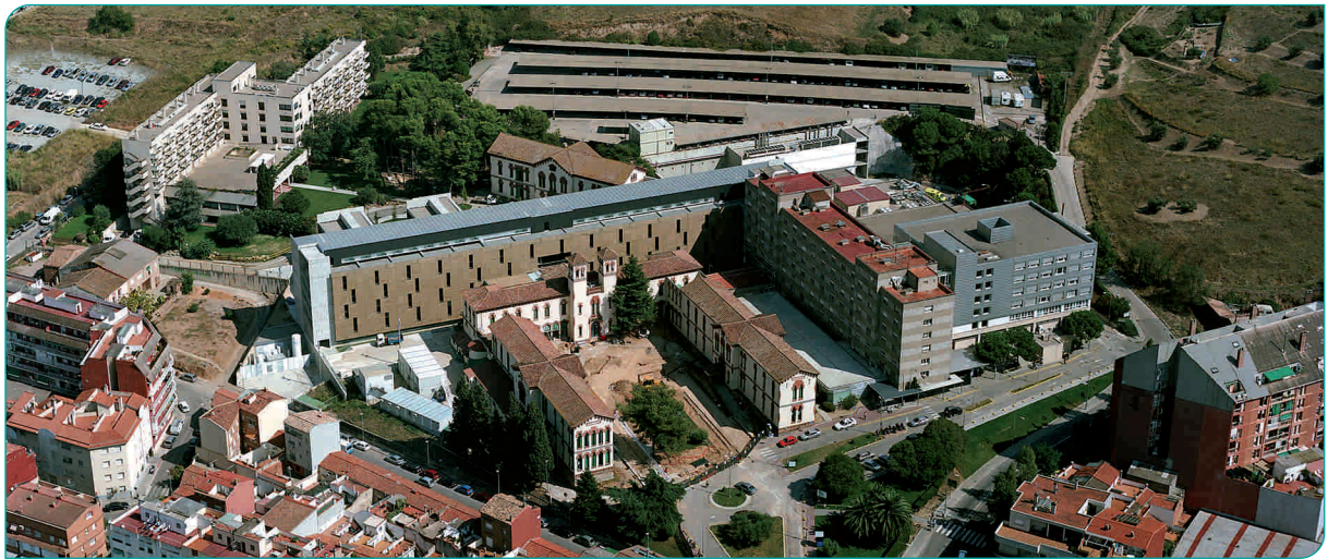
Vista aèria de tots els edificis que formen part de la Fundació Hospital-Asil de Granollers, amb el flamant nou edifici de consultes externes a la part esquerra de la fotografia
