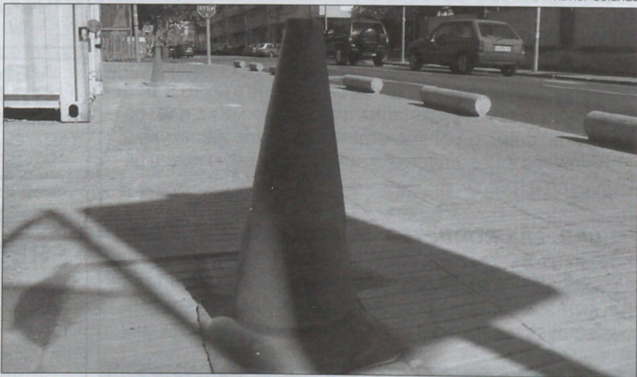
Dos conos advierten a los viandantes que las baldosas están recién colocadas.
