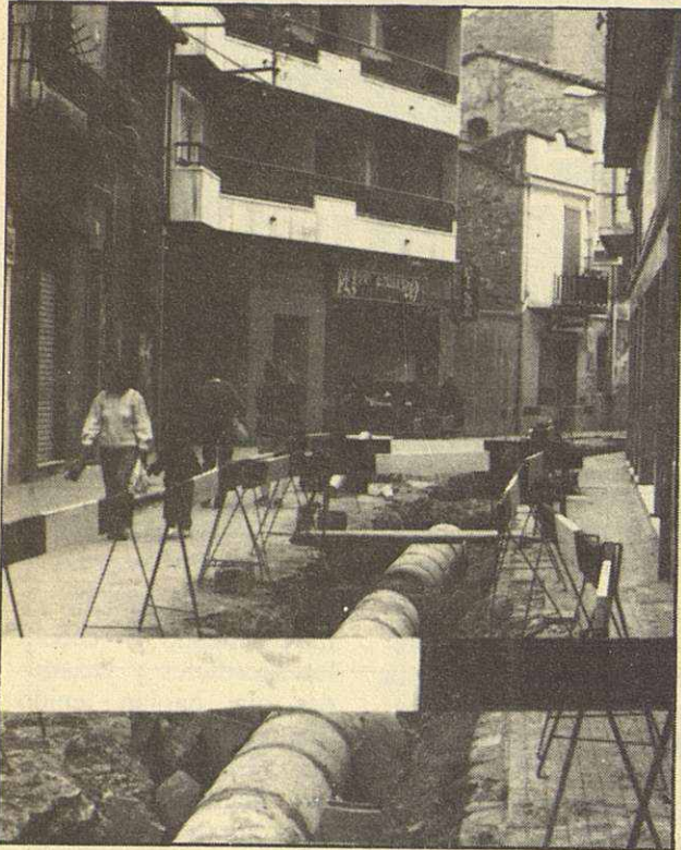
El pasado 13 de octubre se iniciaron las obras de construcción de la segunda fase de la zona peatonal del centro comercial de Mollet del Vallès.
