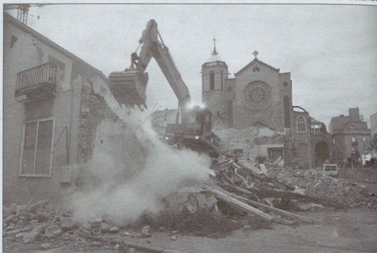
Una imagen para la historia: el derribo de un edificio centenario.
