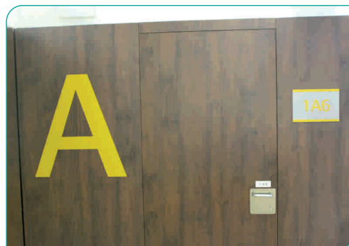
Les portes dels consultoris també estan degudament identificades
