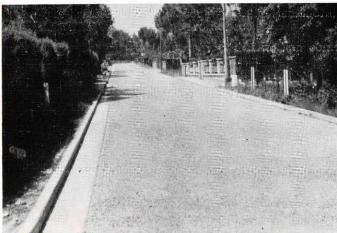
Vista actual de uno de los viales de la Urbanización
