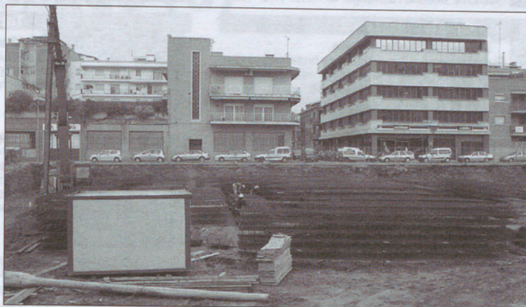
Aspecto de las obras que se están llevando a cabo en la calle Colón.
