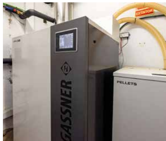
Aquest 2018 s'ha substituït al Centre Cívic de Palou la caldera de gasoil per una de biomassa, que fa servir com a combustible pèl·let d'origen local i certificat
