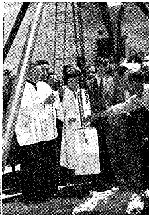
Una instantánea del acto de la colocación de la primera piedra del nuevo edificio de las Escuelas Pías
