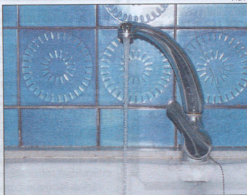
En las viviendas, cuidado con el agua.
