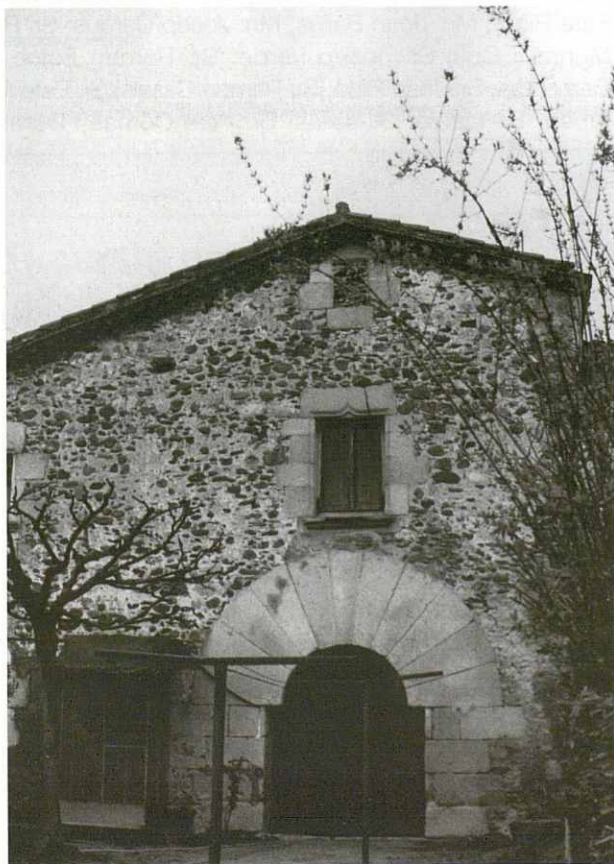
La casa del Rifà amb el portal adovellat i les finestres. Fotografia: Rosa Serra
