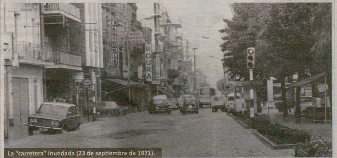
La "carretera" inundada (23 de septiembre de 1971).
